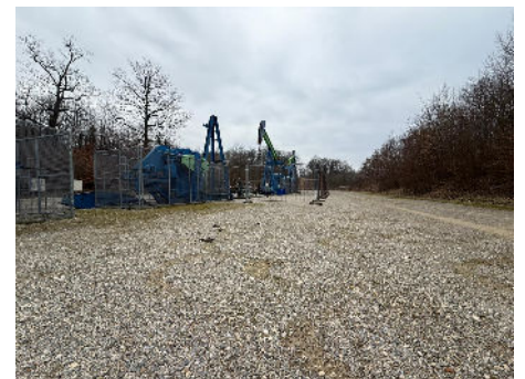
Öl-Bohrstelle im Hochleithenwald
